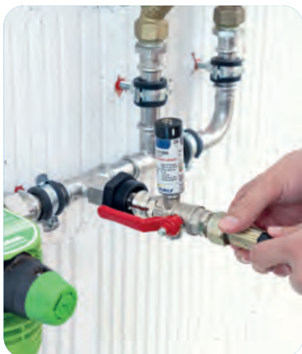
Prüfung der Wasserleitung mit Medium Luft oder Wasser
