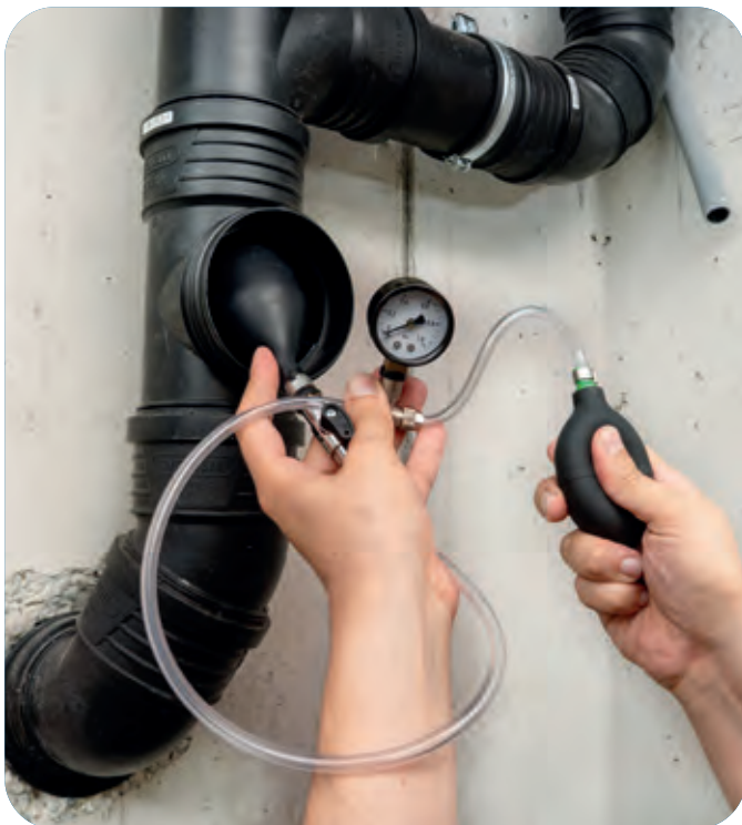
Aufpumpen der Prüfblase mit Blasebalg Prüfblase in der Reinigungsöffnung einer Abwasserleitung
