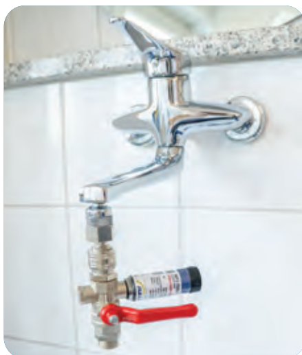
Schlussprüfung auf Dichtheit an Sanitär-Anlagen nach Fertigmontage und vor Inbetriebnahme mit FGP Set
