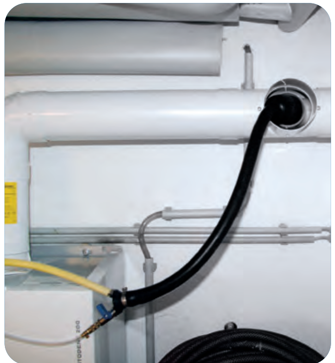
Prüfung eines Brennwertkamins
