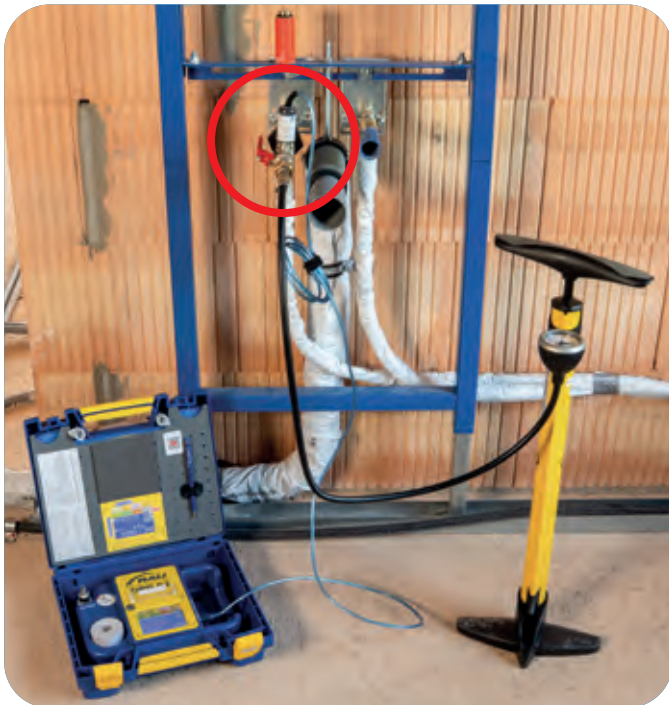
Wasserleitungsprüfung Medium Luft
