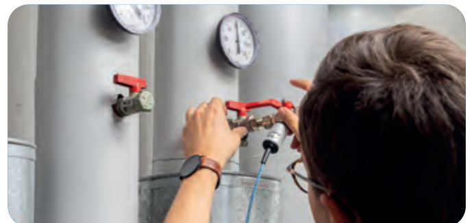
Schlussprüfung Perlator mit FGP Set und Überprüfung Heizung
