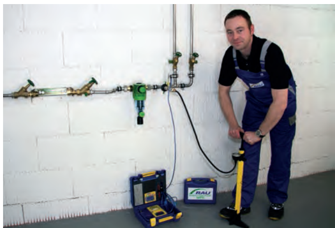
Wasserfestigkeitsprüfung mit Luft.
