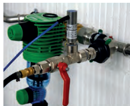
Prüfung der Wasserleitung mit Prüfmedium Luft oder Wasser.
